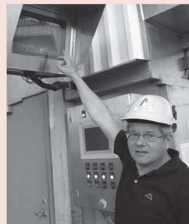
Projektleder Vagn Allentoft viser, hvordan affaldets vej op til ovntrægtene kan følges på de udendørs monitorer.
